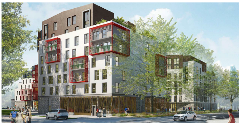
Résidence étudiante à Dijon acquise par le fonds OPPCI Immobilier Impact Investing de Swiss Life Asset Managers France (Patrimoine 24)
